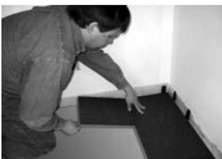
Certifique-se de instalar calços de expansão na parede a partir da segunda linha de montagem. Conecte esta peça, proveniente do corte da última peça da primeira fileira, obedecendo o ângulo entre 20 e 30 graus, com a lateral (B) da primeira peça da primeira fileira. Estas peças cortadas devem ter, no mínimo 20 cm de comprimento.
