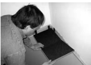
O complemento do corte da última peça desta primeira fileira instalada, servirá como a primeira peça de ponto de partida, do início da montagem da segunda fileira, sendo que a parte onde sofreu o corte transversal, deve ser instalada com sua lateral virada para a parede inicial. Esta forma de aplicação cria um conjunto escalonado em sua visualização (III).
