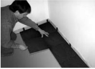
Usando o batedor de madeira e o martelo , faça com que o espaçamento de 6,00 mm, deixado entre estas duas peças, seja conectado de forma correta , sempre focado com o alinhamento correto a ser mantido.
